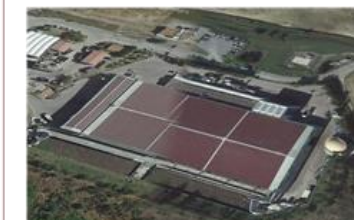
Impianto di compostaggio dei rifiuti
